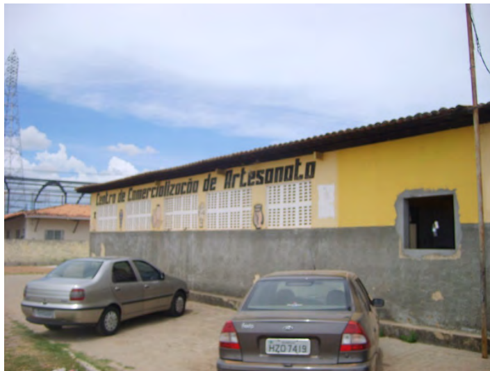
Figura 13: Fachada do Centro de Comercialização de Artesanato.
