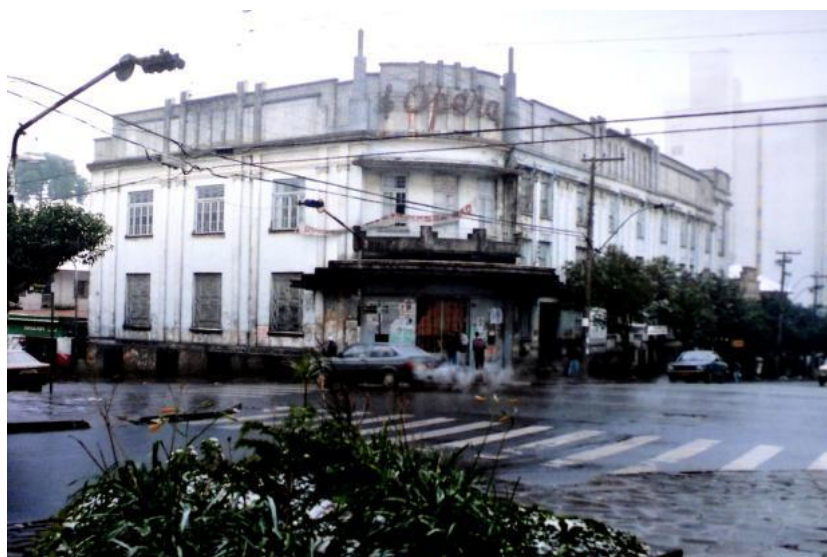
FIGURA 61: Edificação abandonada, 1993 Fonte : Giancarlo Mantovani
