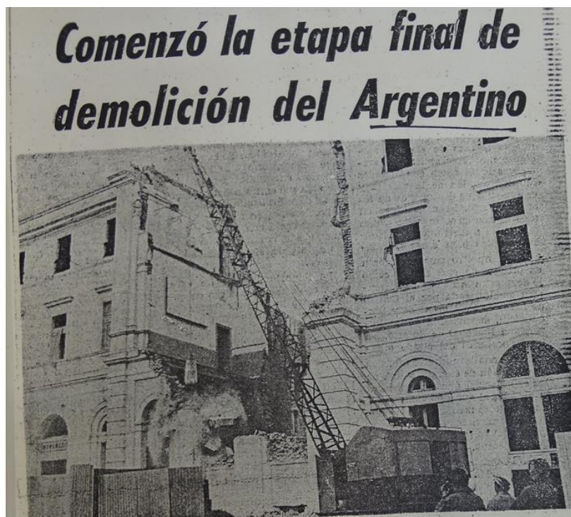
FIGURA 19: Demolição do Teatro Argentino
