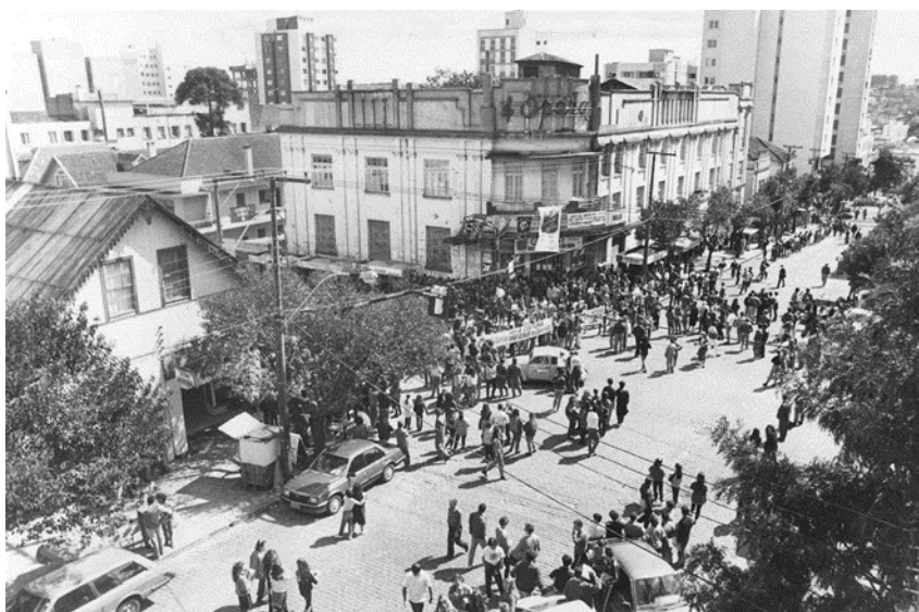
FIGURA 59: Movimento pela preservação: o Abraço ao Ópera em 3 de setembro de 1991. Fonte: Gilmar Gomes, banco de dados/Pioneiro
