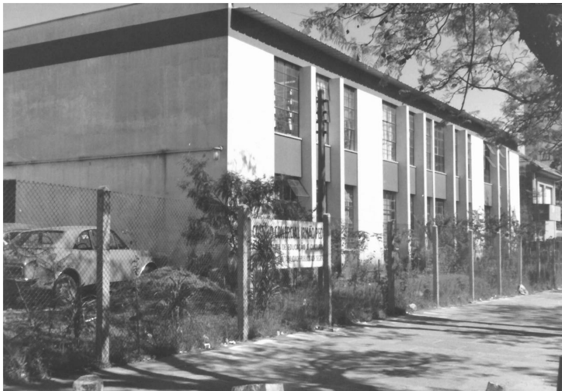
Figura 15 – Fachada do Colégio Comercial Irmão Pedro (1982)
