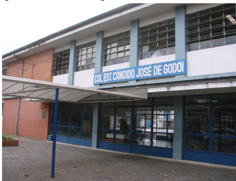
Figura1 – Fachada atual do Colégio Estadual Cândido José de Godói
