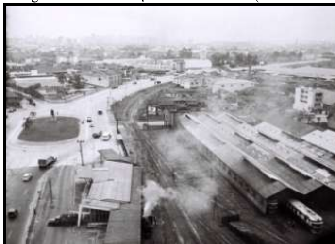
Figura 102 – Antigo terminal da estação Diretor Pestana (no canto inferior esquerdo)
