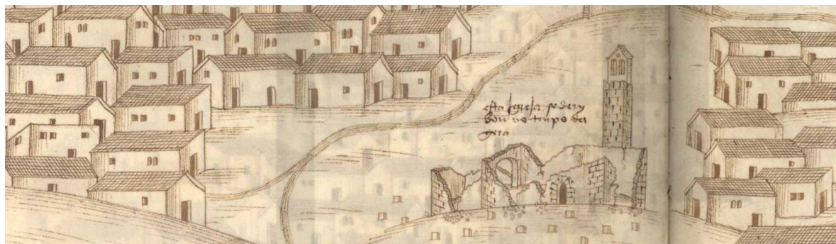
Figura 16: Detalhe da panorâmica de Juromenha (fl.21/N).
