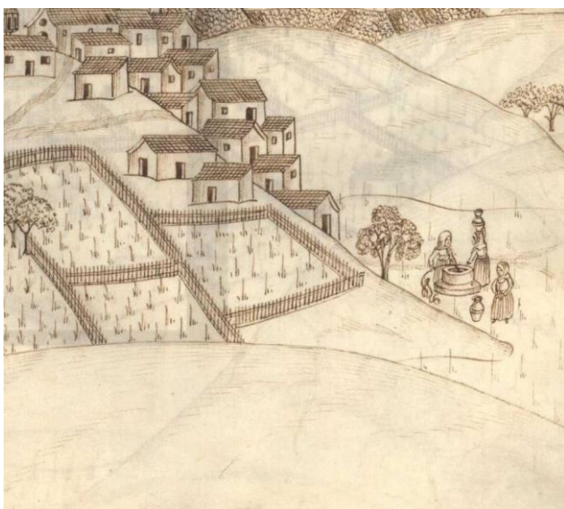
Montalvão (fl.50/S): Detalhe da paisagem de Montalvão. Mulheres buscando água em um poço. Ainda compõe a paisagem uma área de plantio e casas da vila. Fonte: Livro das fortalezas .
