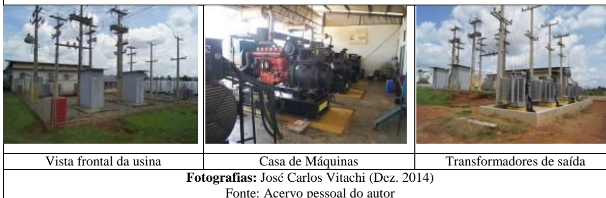
Figura 17 - Usina Termelétrica União Bandeirante
