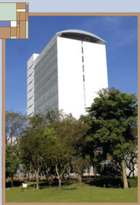
Prédio imponente tem 21 mil metros quadrados
