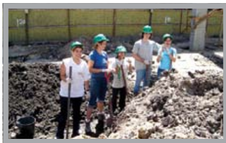
Escavações no Centro Popular de Compras
