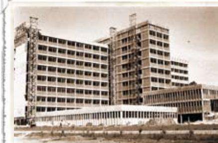
O Hospital São Lucas em obras
