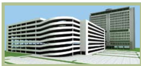
O edifício terá 15 andares e 18.300 m 2
