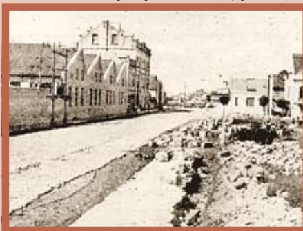
Trecho da Av. Farrapos quase concluído
