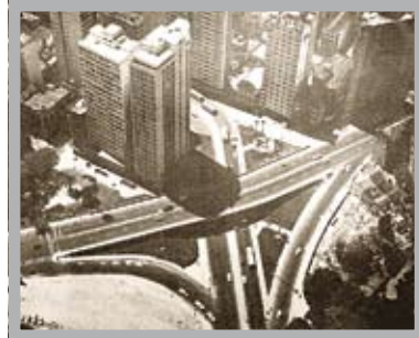
Viaduto Loureiro da Silva
