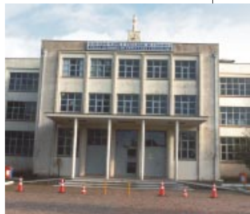
O prédio do antigo Seminário
