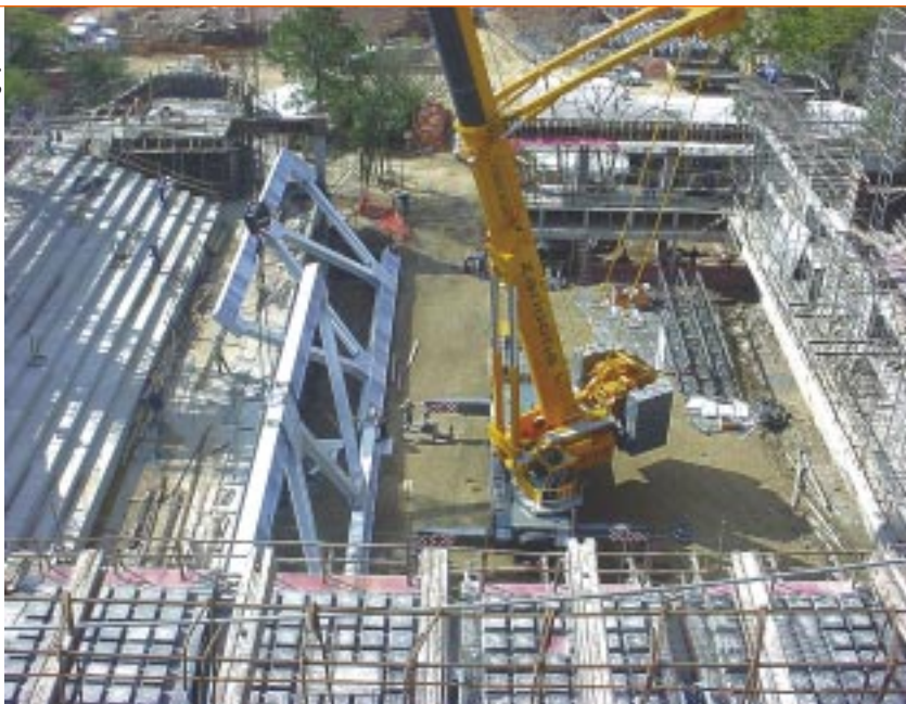
Superguindaste: utilizado na obra para erguer vigas gigantes
