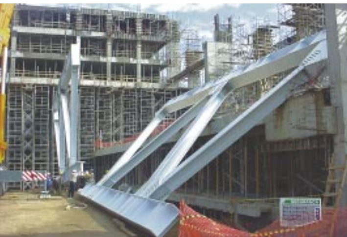
Sustentação: vigas metálicas entre os andares
