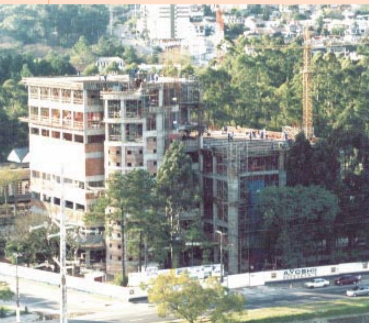
Obra cresce na Av. Ipiranga, em frente ao Campus
