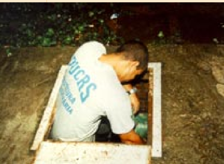
Ar condicionado: dutos conduzem água gelada
