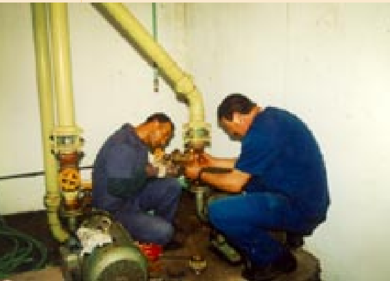
Sistema hidráulico: manutenção de canos
