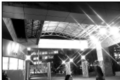
Pórtico de entrada
