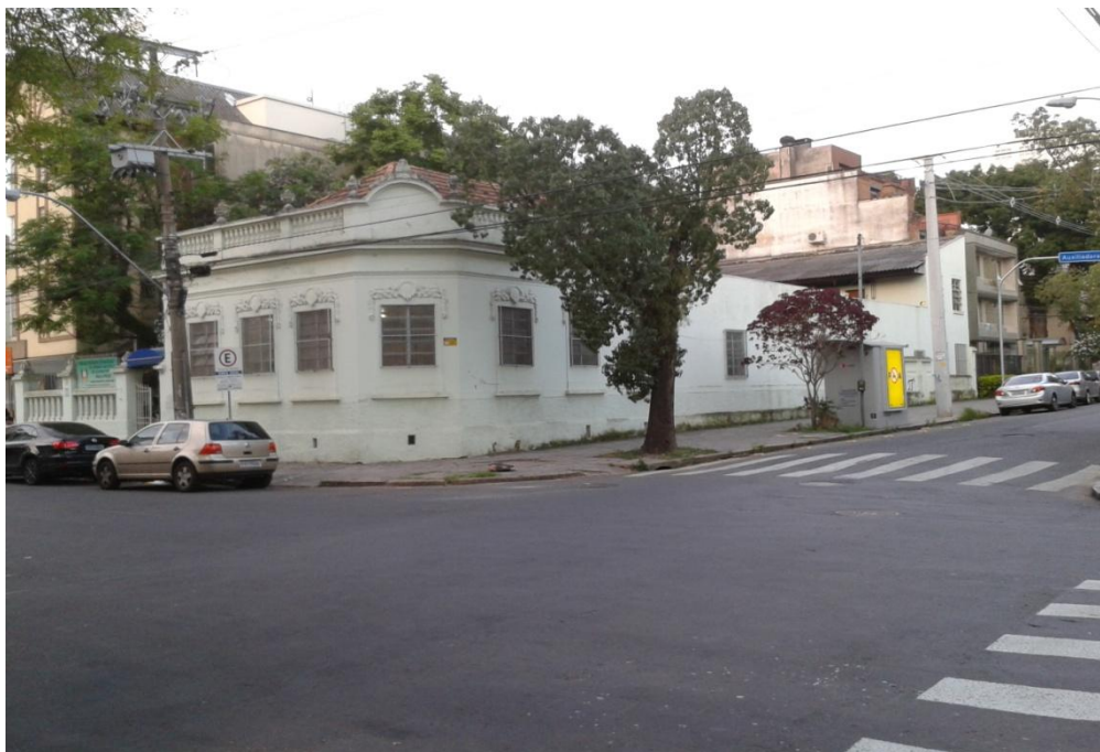
Figura 6: Foto da fachada do prédio principal do NEEJA (outubro/2013). Fonte: Autora da dissertação.
