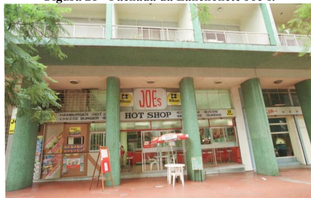
Figura 28 - Fachada da Lanchonete Joe’s.
