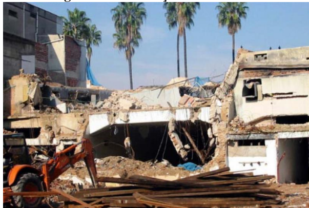
Figura 50 - Demolição do Baltimore.
