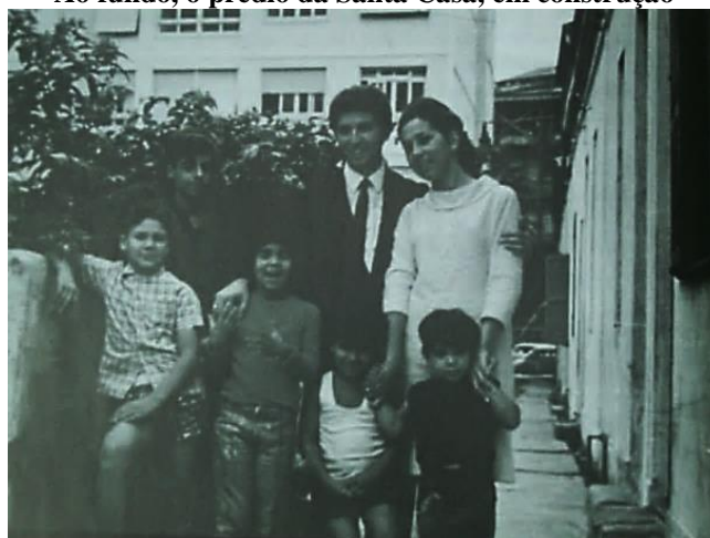
Figura 22 - Lawson Pereira, Teresinha Melo Fernandes e filhos. Ao fundo, o prédio da Santa Casa, em construção
