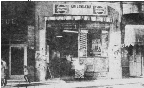
Figura 39 - Fachada do bar Lola 305 .
