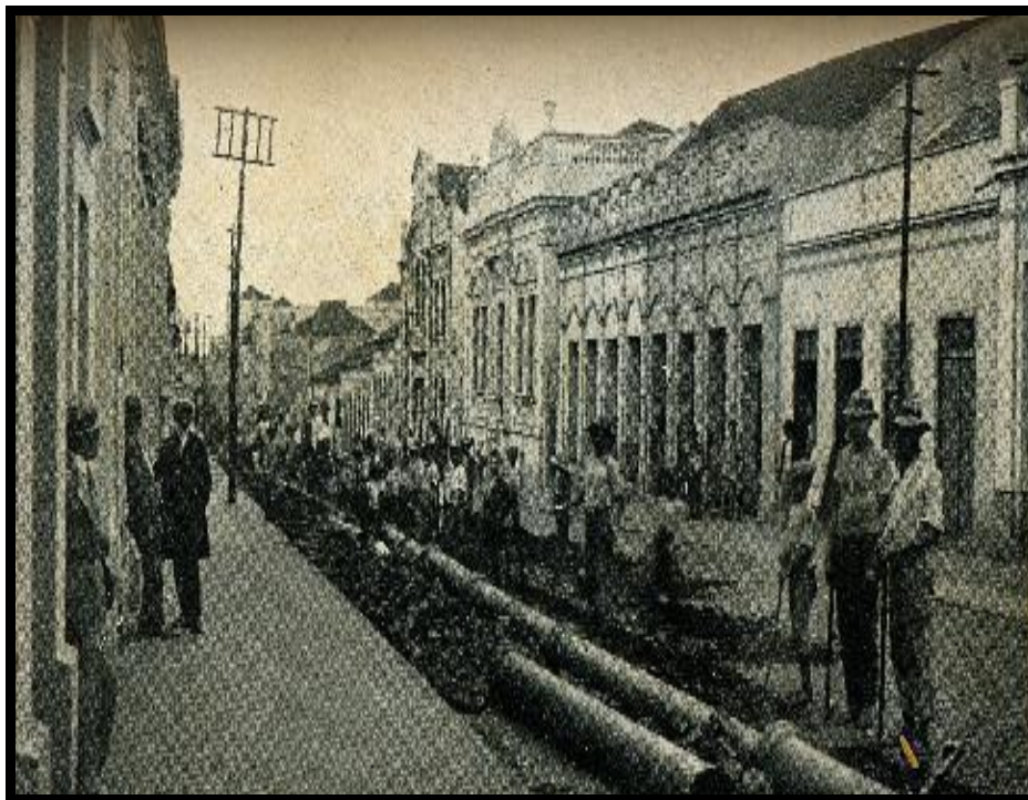
Figura 26: Assentamento de condutos, em uma via pública, de Cruz Alta.
