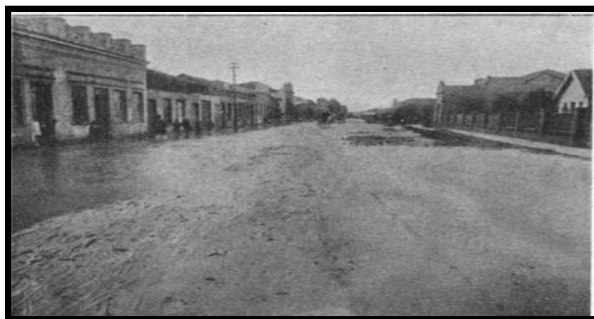
Figura 38: Rua Marechal Deodoro após chuvas intensas em junho de 1928.
