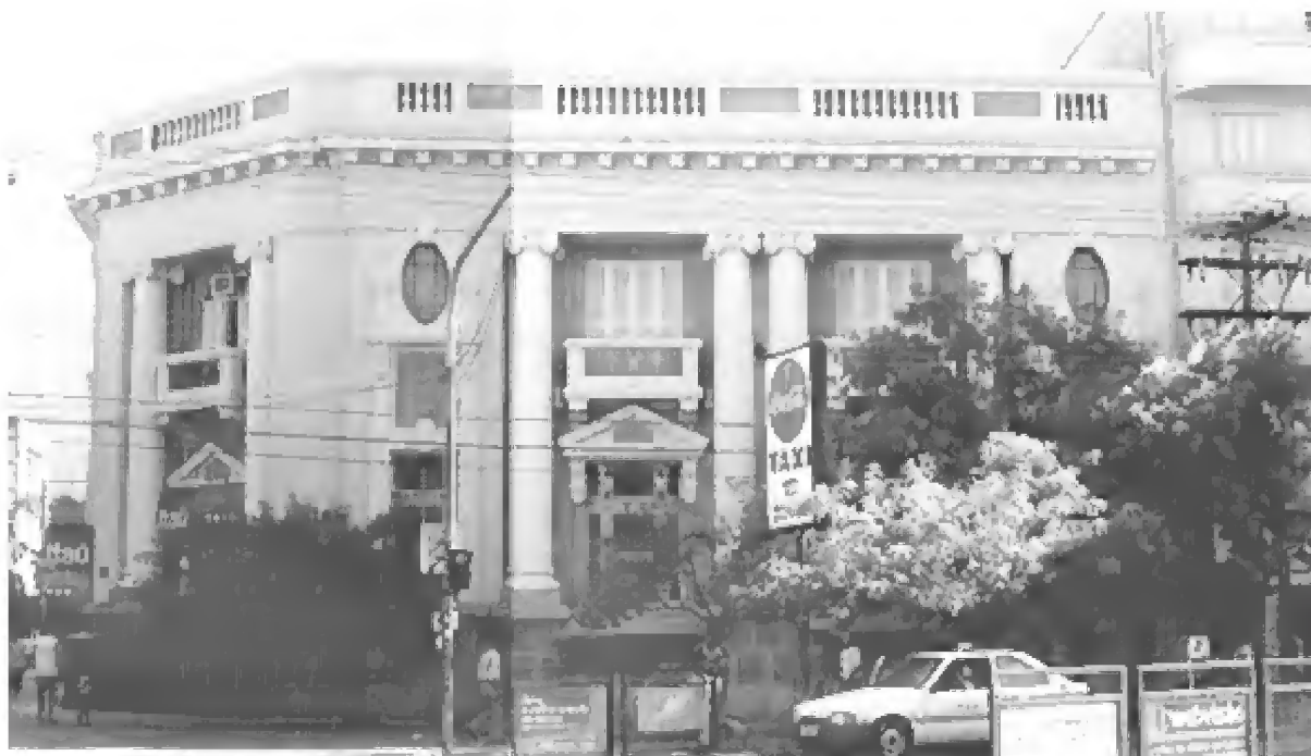
Fig. 48 – Banco da Província, atual Banco Itaú.
