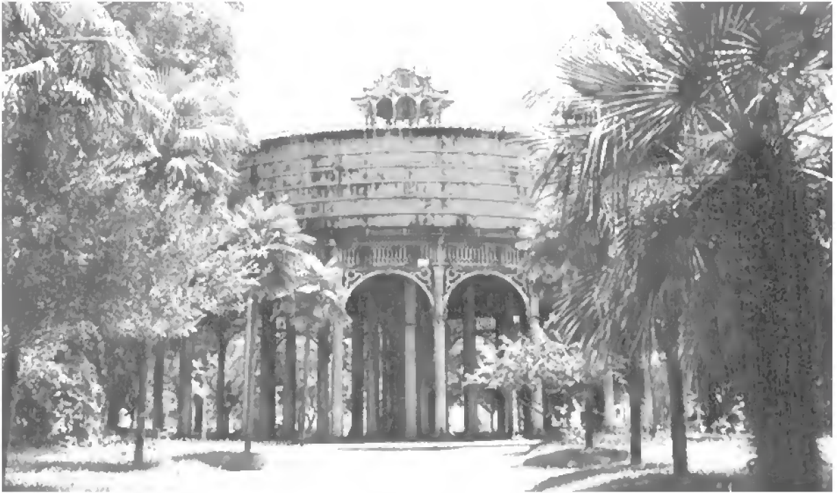
Fig. 115 – Caixa d'Água de Ferro Fonte: Fotos de Neco Tavares, 2000
