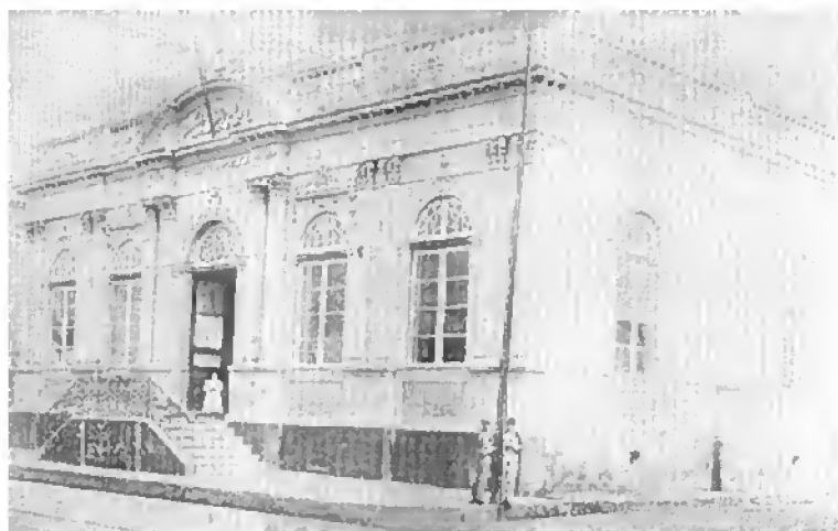
Fig. 34 – Biblioteca Pública, antes da reforma.
