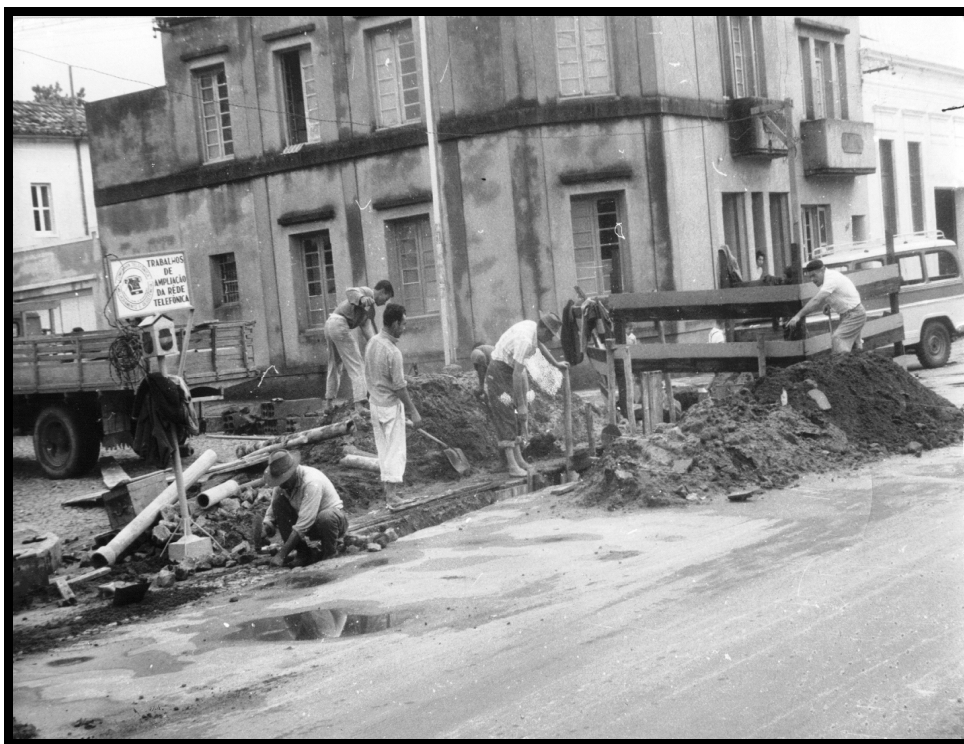
Figura 19 – Abertura de Valetas para colocação de cabos subterrâneos (S/d)
