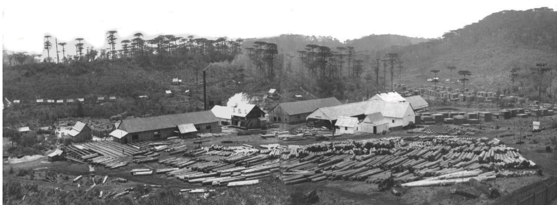
Figura n. 26: Serraria da Fazenda São Roque, complexo madeireiro extrativo da Lumber
