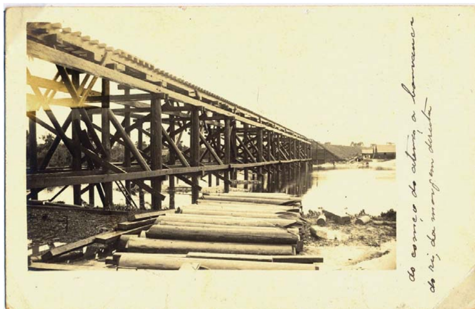
Figura n. 06: A construção da ponte sobre o Rio Iguaçu
