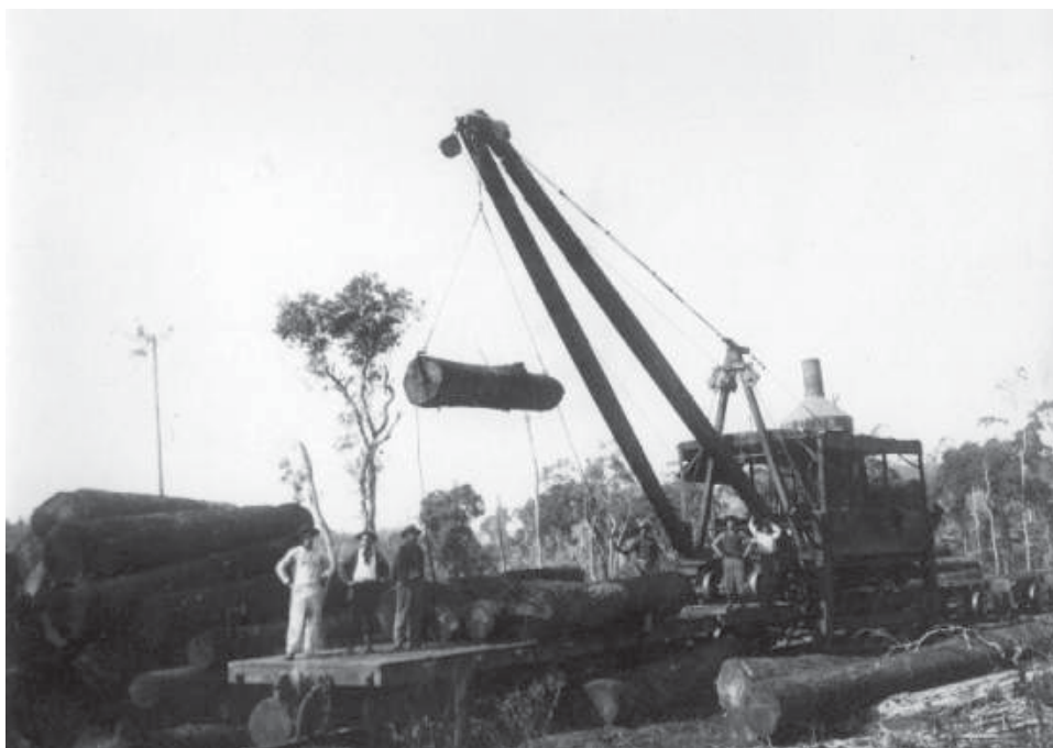
Figura n. 37: Guinchos que arrastavam e que carregavam toras
