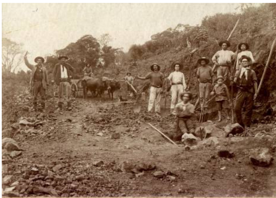
Figura 33 – Grupo de homens nos trabalhos de construção de estrada, 12x17 cm. Foto de Adam Klos, Neu-Württemberg, s./d. Fonte: Acervo do MAHP
