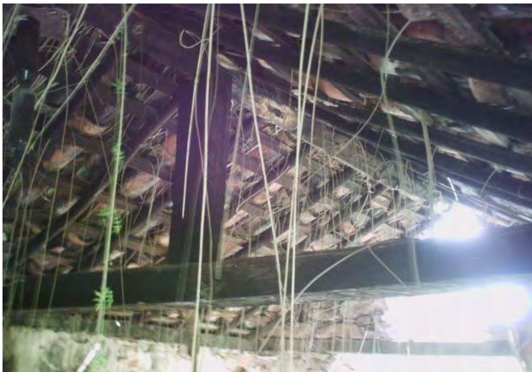
Figura 49: Tesoura e treliça em madeira sustentam o telhado da senzala na estância Vista Alegre. Fonte: acervo da autora (foto de autoria de Paulo Roberto Koch Jr., em 06/02/2007).
