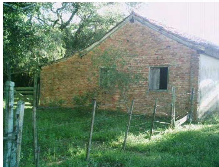
Figura 85: Lateral do galpão. Fonte: Arquivo da autora.
