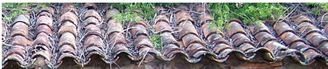
Figura 30: Telhado da senzala da estância Vista Alegre. Fonte: Arquivo da autora (25/08/2006).
