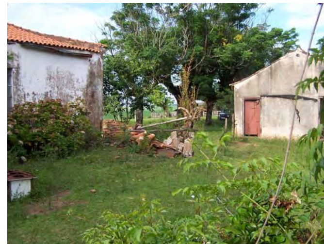
Figuras 79 a 81: Vista que se tem a partir da porta central da fachada da senzala. Fonte: Arquivo da autora.
