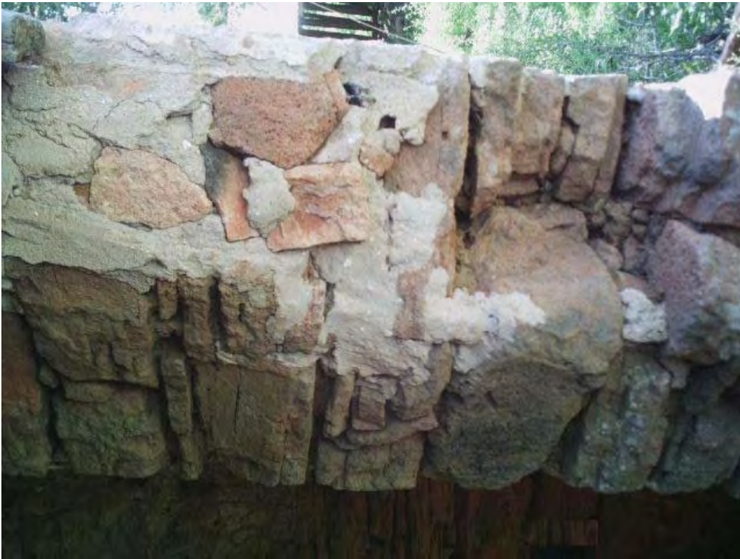
Figura 47: Parede da senzala, medindo 0,48 m de largura. Fonte: Arquivo da autora (06/02/2007).
