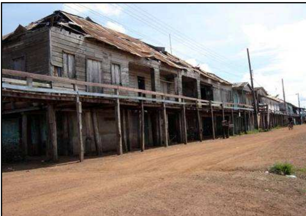
Fig. 43. Foto das casas sobre palafita no município de Costa Marques, Rondônia. Foto de Edu Jung. Fonte: http://www.panoramio.com/ . Acesso em dezembro de 2007.
