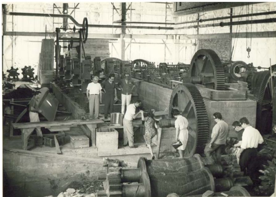
Fotografia 75 – Moendas da AGASA em instalação – 1964
