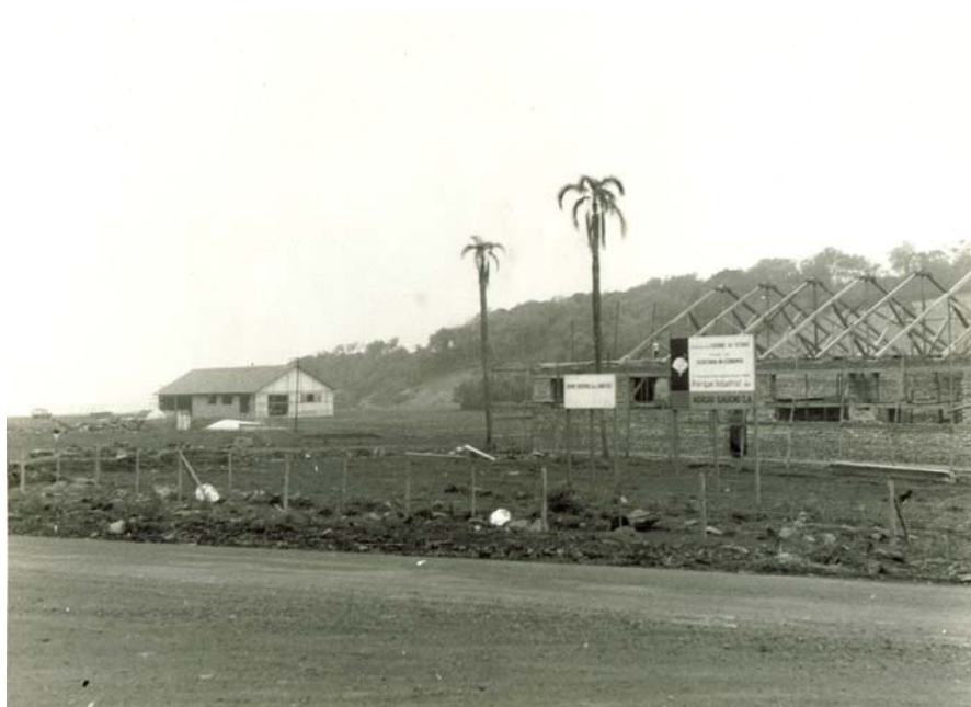
Fotografia 55 – Vista panorâmica da área do parque industrial da AGASA, vendo-se, à beira da RS 17 (atual RS 30), as primeiras obras – 1963
