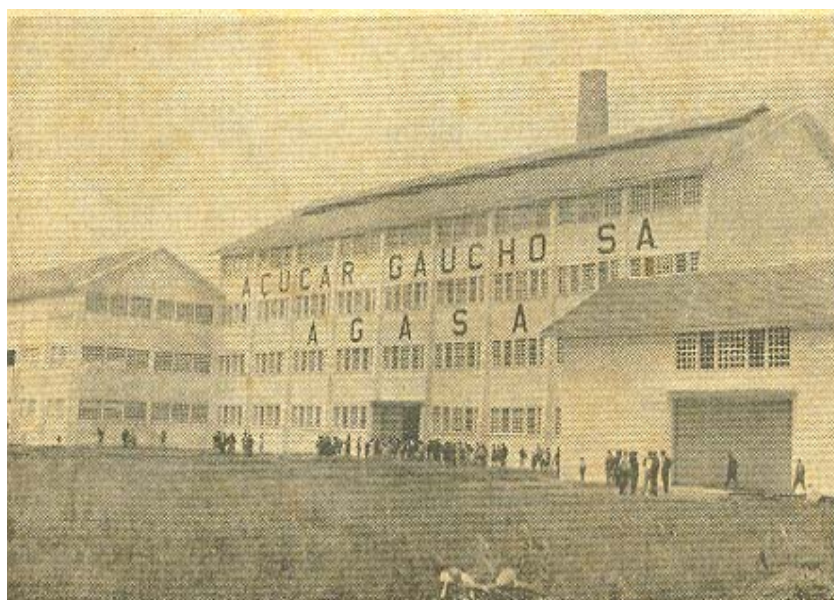
Fotografia 65 – Vista da fachada principal da usina, vendo-se, em frente, na área de acesso, parte do público que compareceu ao ato inaugural – 15/11/1965
