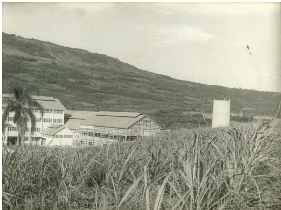
Fotografia 56 – Morros da cana, a fábrica e a chaminé da AGASA em construção – 1964
