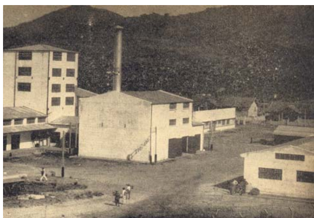
Fotografia 13 – Vista panorâmica do complexo industrial da Destilaria Livramento – 1957
