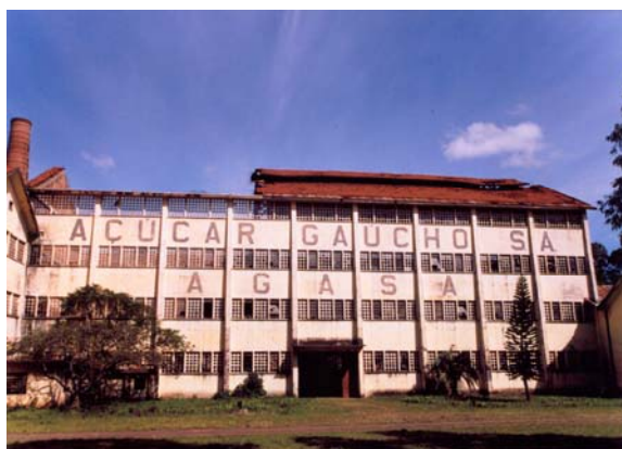
Fotografia 116 – Açúcar Gaúcho S.A. – AGASA em ruínas – setembro de 2006
