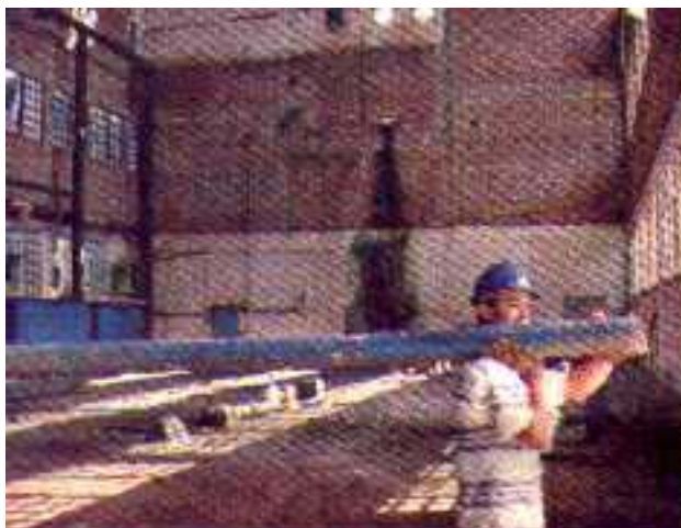
Fotografia 114 – Outro aspecto da retirada do maquinário da usina – 2003
