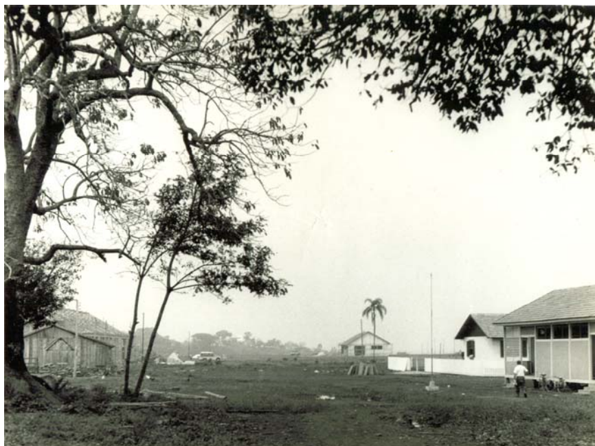
Fotografia 54 – Vista panorâmica da área do parque industrial da AGASA em construção
