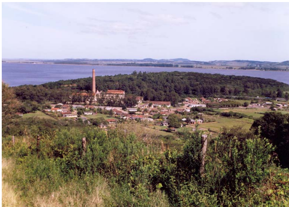
Fotografia 127 – Restos do complexo industrial AGASA – setembro de 2006
