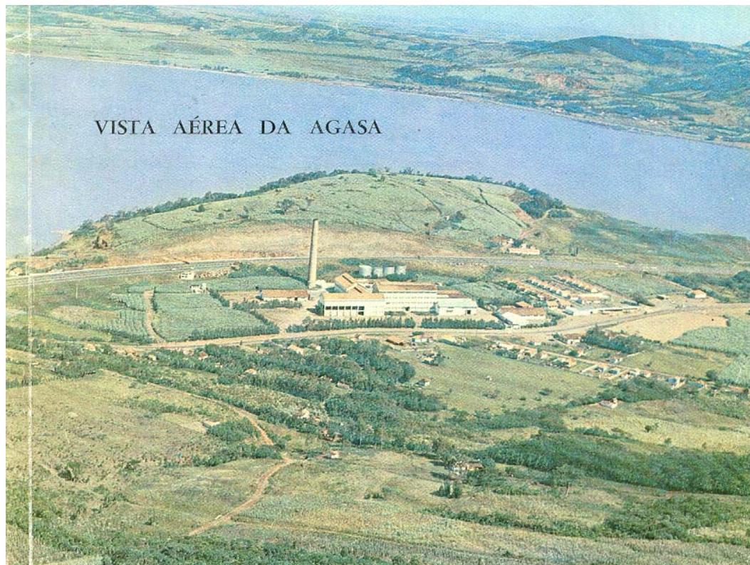
Fotografia 73 – Vista aérea do complexo industrial da AGASA – 1974
