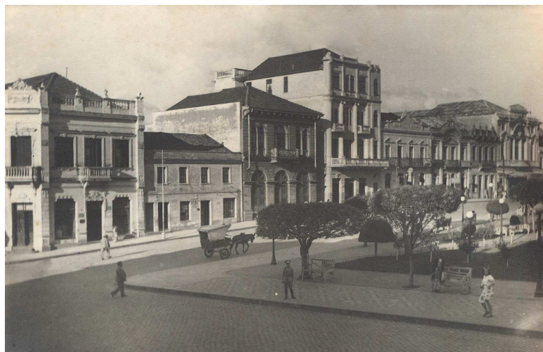
Figura 1 - Entroncamento Av. Julio de Castilhos e Rua Dr. Montaury, 1947.
