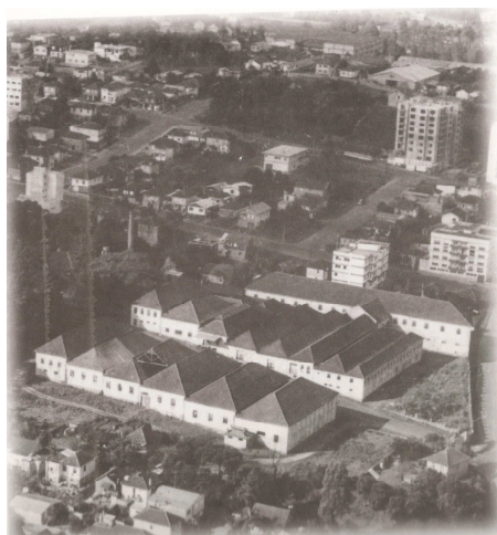
Figura16 – Complexo antes da destruição, 1985.
