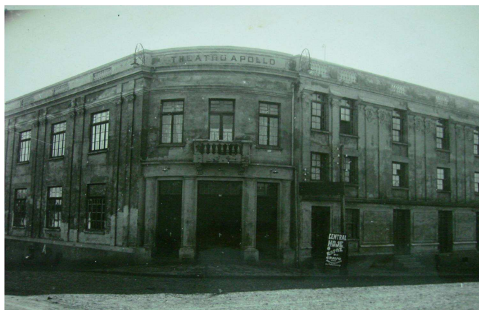
Figura 21- Após sua construção, década de 1930.
