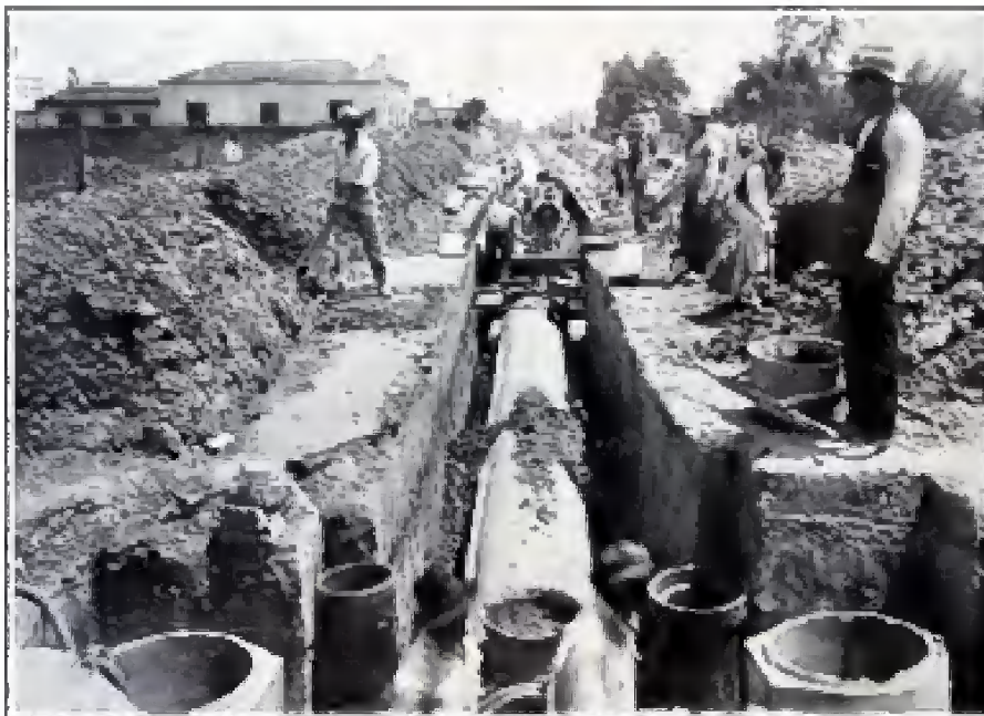
Figura 40 – Obras da rede de esgoto
