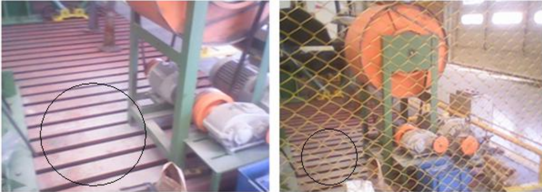
Figura 5.5. Fuga do abrasivo externo a bancada.
