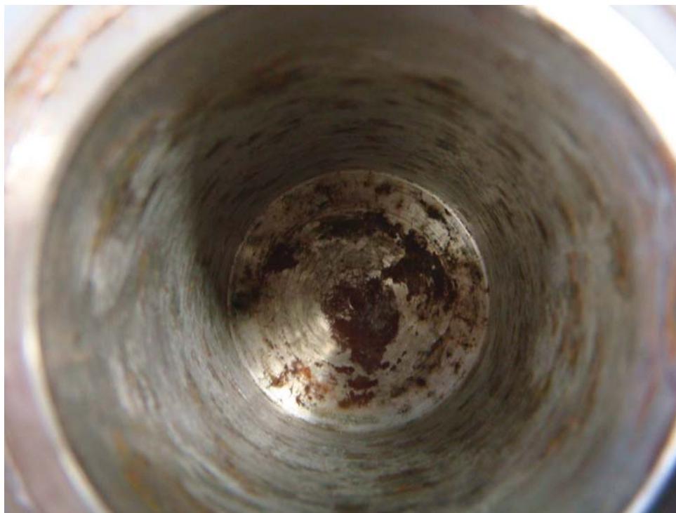
Figura 5.14: Corrosão do reator de aço inoxidável
