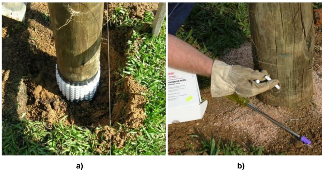
Figura 3.5. Aplicação dos Preservantes: Em a) Externo na forma de bandagem ( Bioguard ) e b) Interno na forma de bastonetes ( Polesaver ).
