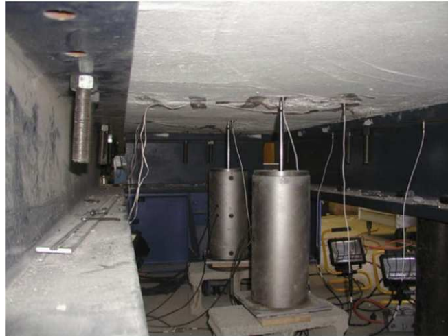
Figura 3.11. Fotografia mostrando os sensores montados na superfície de trás da laje (Zineddin e Krauthammer, 2007).
