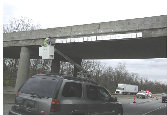
Figura 3.8. a) Núcleo de compósito tipo honeycomb (dimensões:304,8X304,8 X203,2 mm) b) Núcleo de compósito tipo honeycomb usado para aumentar a capacidade de absorção de energia de viga de ponte (Yang e Qiao, 2010).
