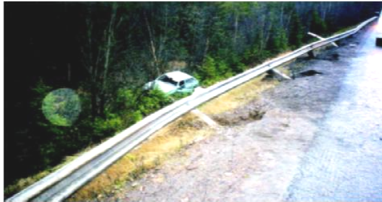
Figura 3.6. Saída de pista devido à interação fraca solo-poste de um guard rail (Wu e Thomson, 2007).
