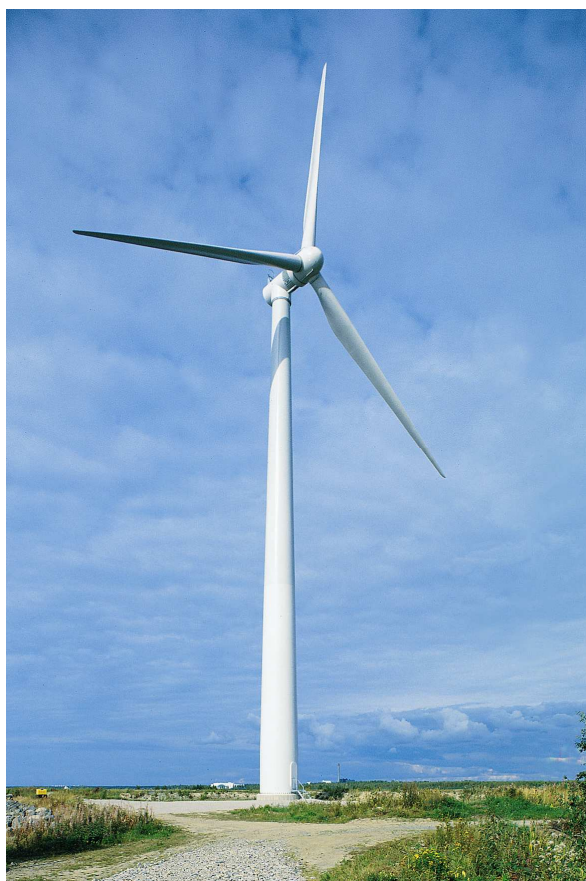
Figura 1.6. Modelo atual de aerogerador de eixo horizontal com pás em resina epóxi reforçadas com fibra de vidro.
