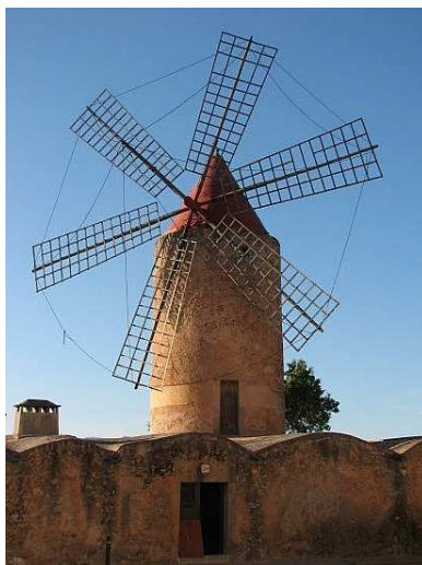
Figura 1.3. Moinho de vento, geração de potência mecânica através da captação de energia eólica.
