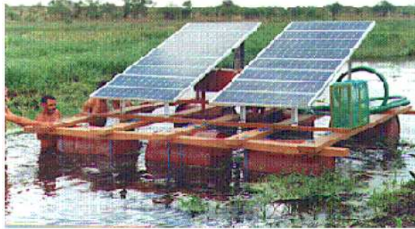
Figura 1.1 – Sistema de bombeamento fotovoltaico em Valente – BA – Brasil [2].
