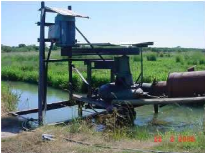
Figura 5.9. Instalação Obsoleta e Apresentando Baixa Eficiência Operacional. Fonte: Relatórios Energéticos Produzidos pelo GEE.
