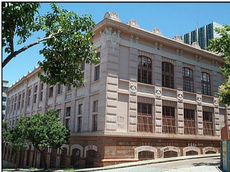
Figura 21: Vista de uma das laterais e dos fundos do prédio, pela Rua Fernando Machado. (Fonte: Arquivo particular, 2008)
