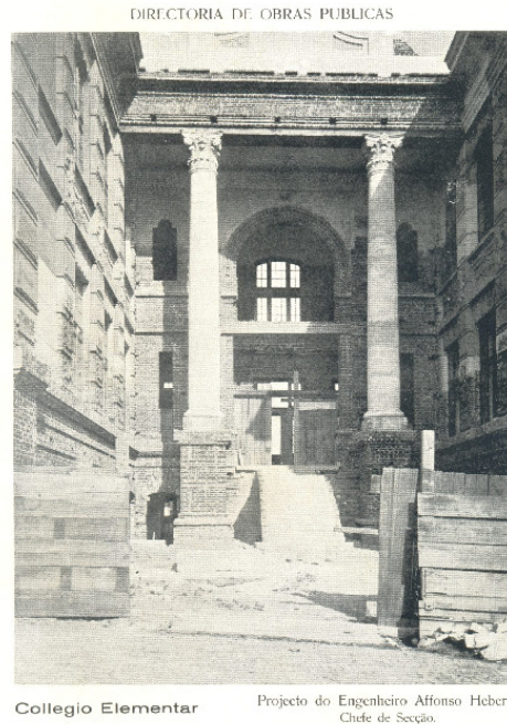
Figura 15: Acesso principal do Colégio, em construção - 1918. (Fonte: Mapoteca da Secretaria de Obras Públicas do Estado do Rio Grande do Sul)
