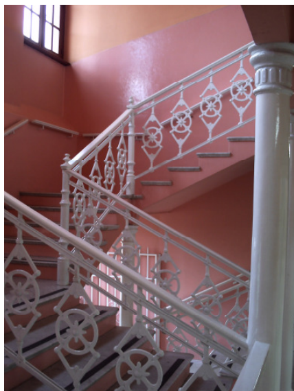
Figura 31: Vista lateral da escadaria central. (Fonte: Arquivo particular, 2010)
