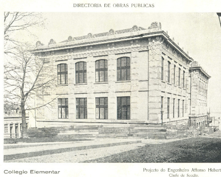
Figura 16: Lateral do Colégio, em construção - 1918. (Fonte: Mapoteca da Secretaria de Obras Públicas do Estado do Rio Grande do Sul)
