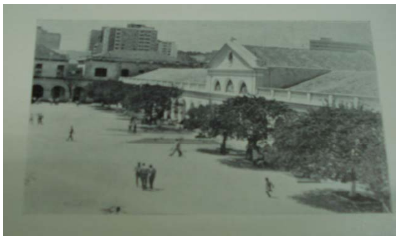
Figura 53: Vista pátio interno do CMPA Fonte: Revista Hiloea (1968)
