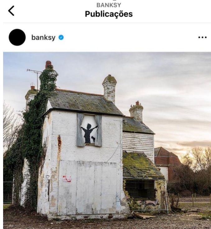
Figura 17 - Foto do mural Morning is Broken antes da demolição
