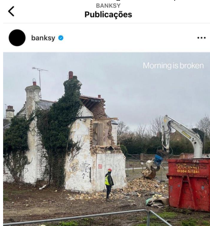
Figura 18 - Foto do mural Morning is Broken após a demolição
