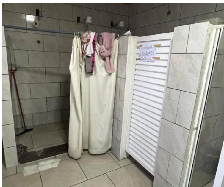
Figura 4. Banheiro do alojamento feminino do Presídio Regional de Caxias do Sul/RS
