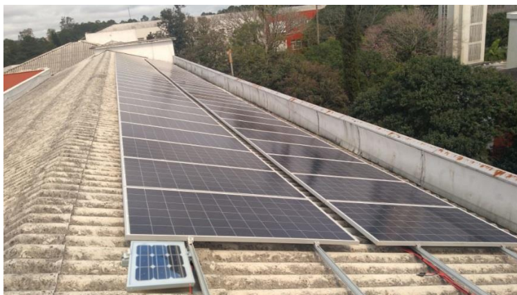
Figura 27: Fixação da célula solar de referência próxima ao arranjo G4.
