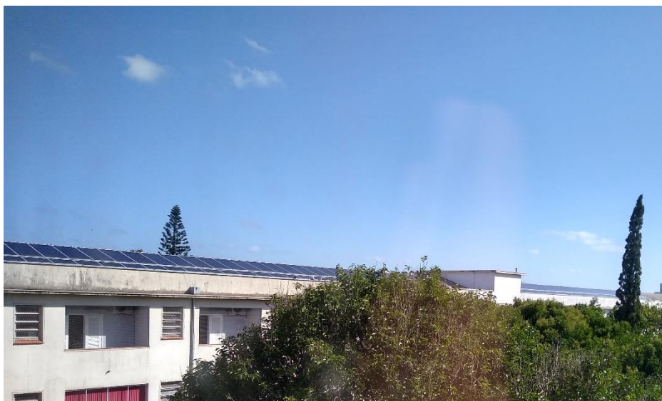
Figura 28: Visão da infraestrutura parcial do telhado A/E no TECNOPUC, Viamão
