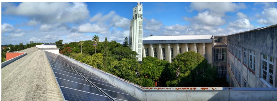
Figura 29: Visão panorâmica da infraestrutura do prédio 87, TECNOPUC, Viamão.
