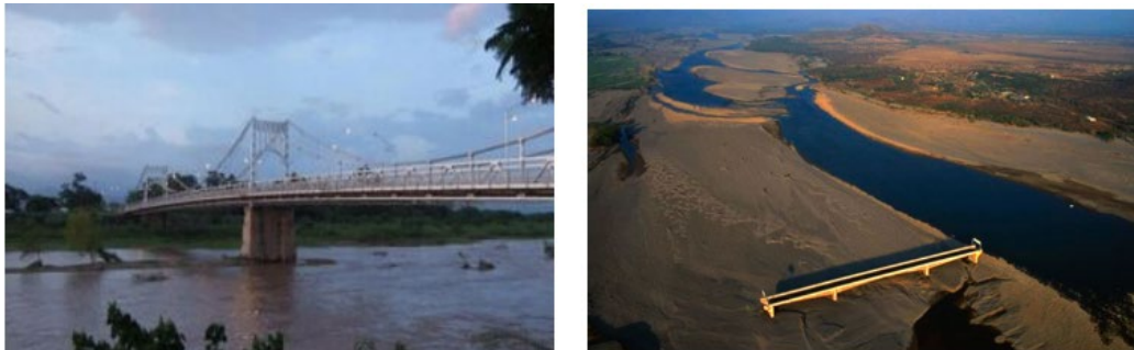
Figura 1 – Ponte de Choluteca, Honduras, antes e após a passagem do furacão Mitch
