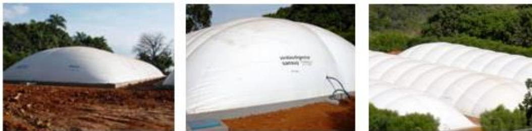
**Figura 1-** Biodigestor para resíduos de suínos
