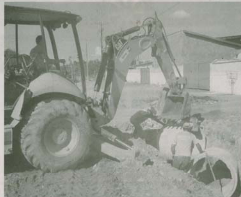
Município é beneficiado com obras de infraestrutura que melhorará escoamento de águas pluviais
