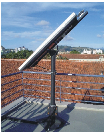
Figura 5. Módulos fotovoltaicos instalados em Porto Alegre, com um ângulo inclinação de 49^\circ .
