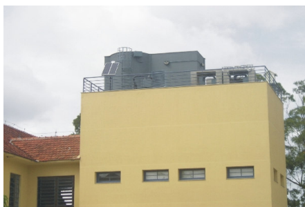
Figura 6. Laboratório de Medidas Externas do NT-Solar, com os módulos fotovoltaicos instalados.
