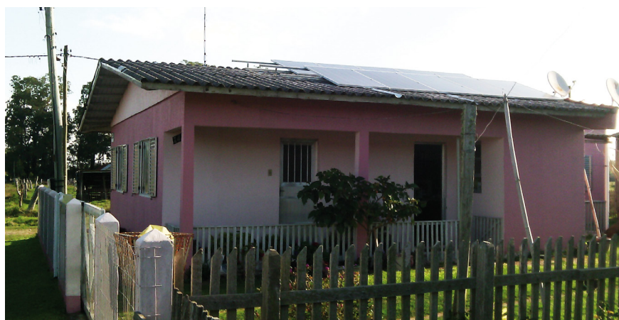
FIGURA 12. Residência de pescador artesanal com sistema on grid instalado – Tavares.
