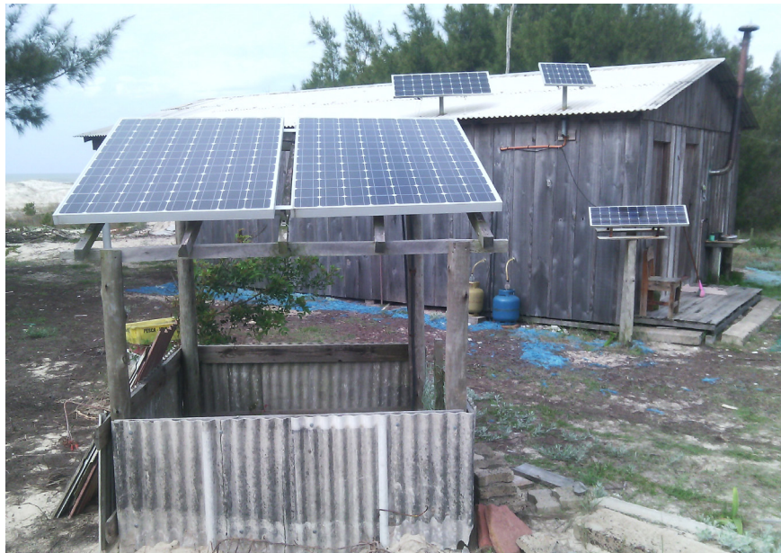
FIGURA 11. Residência de pescador artesanal com sistema solar off grid instalado – Mostardas.
