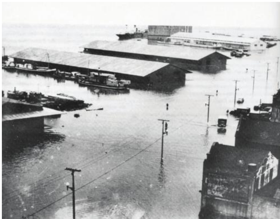
FIGURA 6 - Armazéns do Cais do Porto tomados pela água (1941)
