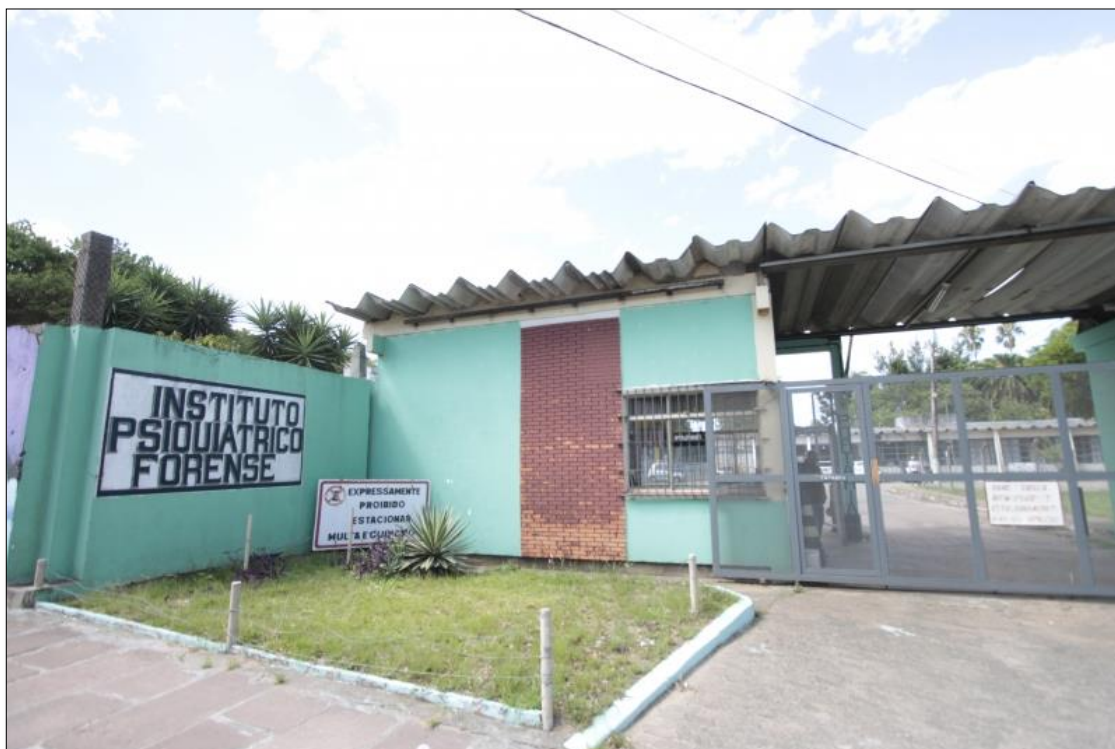
Figura 3 - Fachada Instituto Psiquiátrico Forense Mauricio Cardoso
