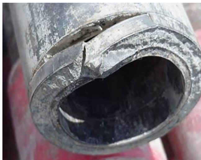
Figura 3.1. Corrosão em tubo de aço (oleoduto e gasoduto) devido a presença de H 2 S. Fonte: Popoola et al. (2013).
