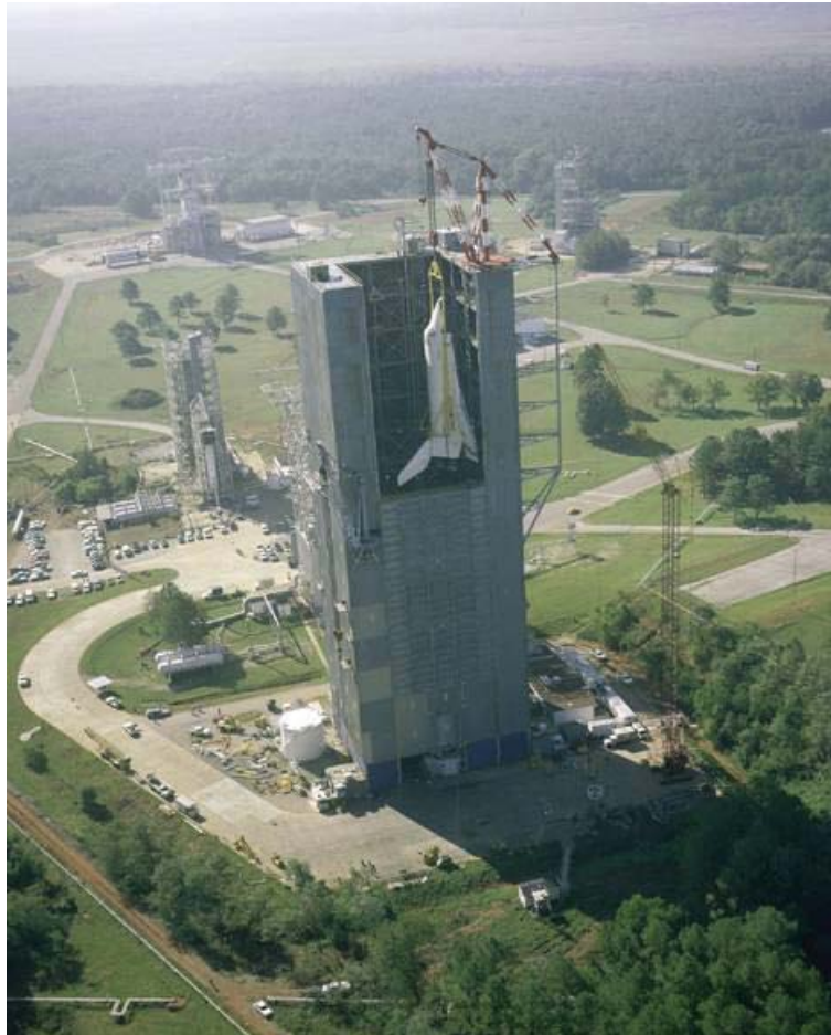
Figura 1: Teste de vibração no ônibus espacial Enterprise em 1978 - NASA
