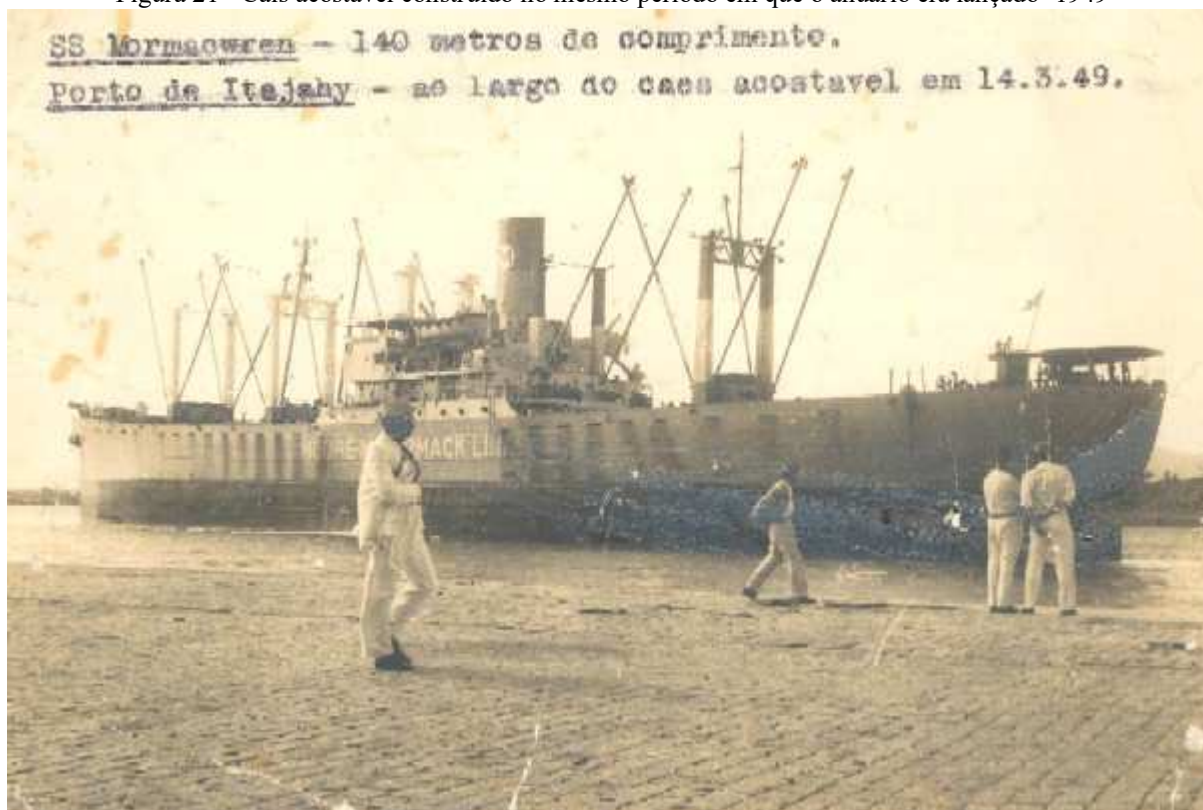
Figura 21 - Cais acostável construído no mesmo período em que o anuário era lançado- 1949
