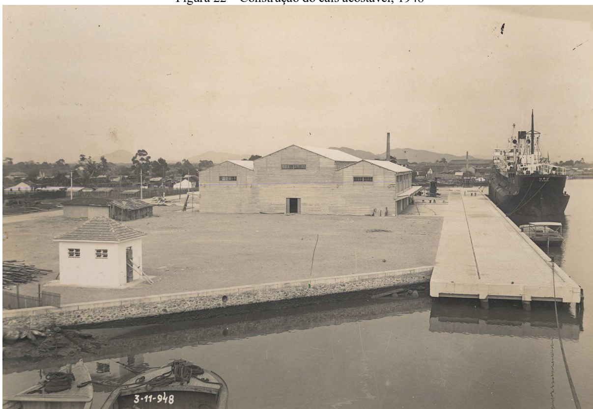
Figura 22 – Construção do cais acostável, 1948
