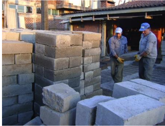
Figura 3 – Processo de armazenamento dos blocos após a cura
