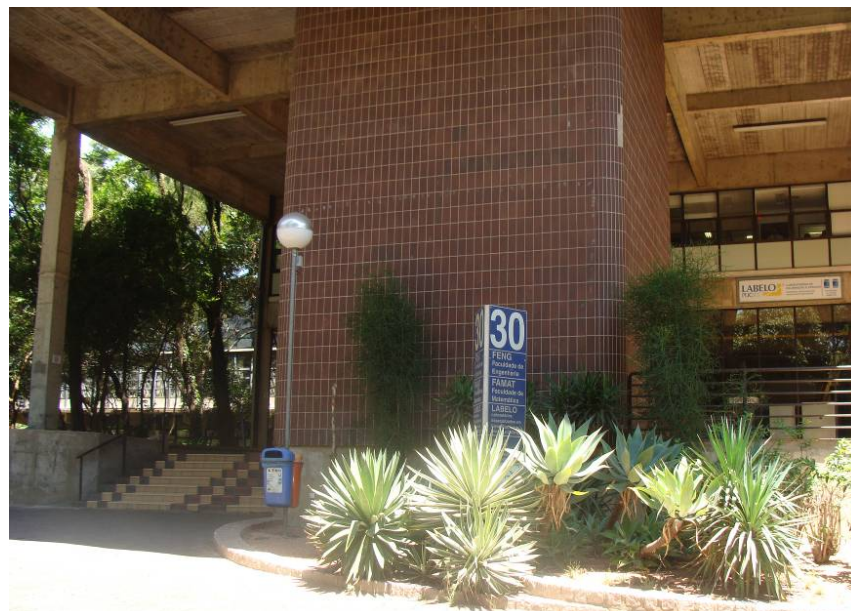
Figura 6 - Vista externa do prédio 30 da PUCRS - FENG
