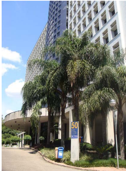
Figura 2 - Vista externa do prédio 50 da PUCRS - FACE
