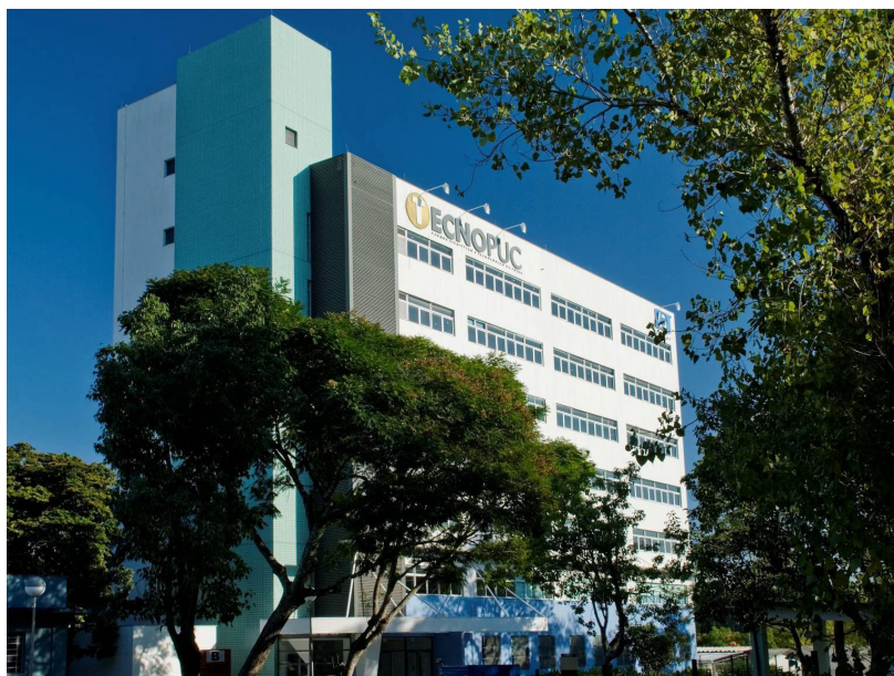
Figura III-28. Prédio 95C construído para acomodar projetos de P&D&I com a DELL e a HP.
