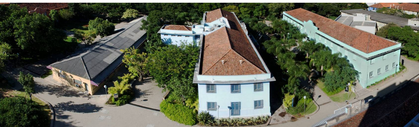
Principais prédios do 18º Batalhão de Infantaria Motorizada já reformados pelo TECNOPUC.
