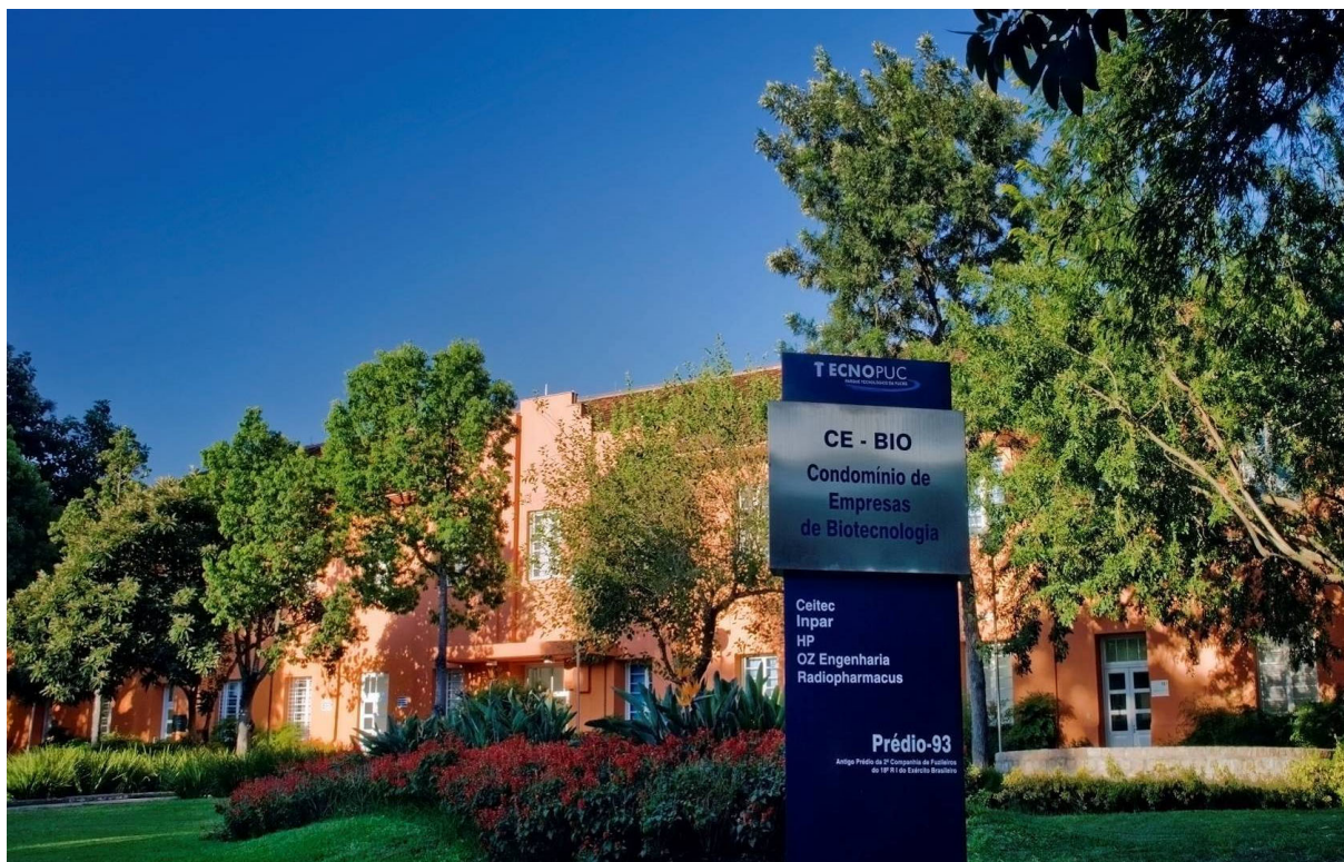
Prédio da 2ª Companhia de Fuzileiros do 18º Batalhão de Infantaria Motorizada reformado e destinado a empresas das áreas de ciências biológicas, da saúde e de biotecnologia.
