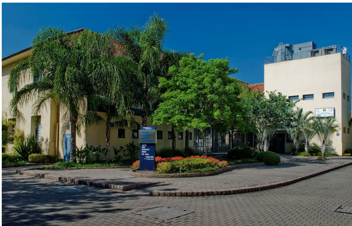
Prédio da 3ª Companhia de Fuzileiros do 18º Batalhão de Infantaria Motorizada reformado e destinado a laboratórios de energia e física aplicada.
