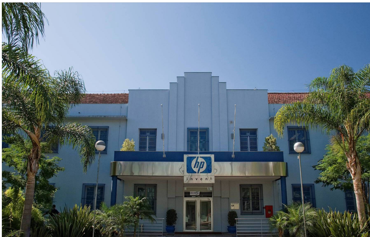
Prédio da Companhia de Comando e Serviços e refeitório dos oficiais do 18º Batalhão de Infantaria Motorizada reformado e destinado a HP.
