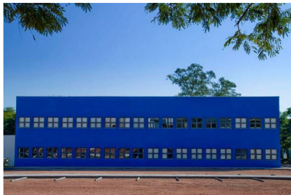
Figura III-32. Prédio do CEPAC.
