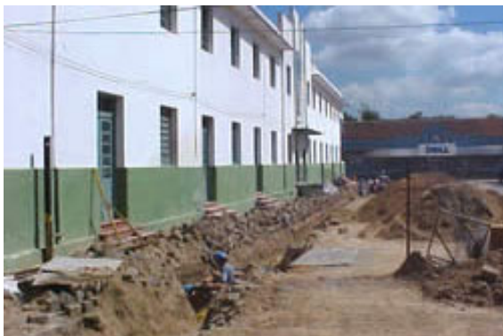
Figura III-9. Em 2002, o prédio do Global Development Center da DELL já fora inaugurado, mas continuavam as obras nos prédios vizinhos.
